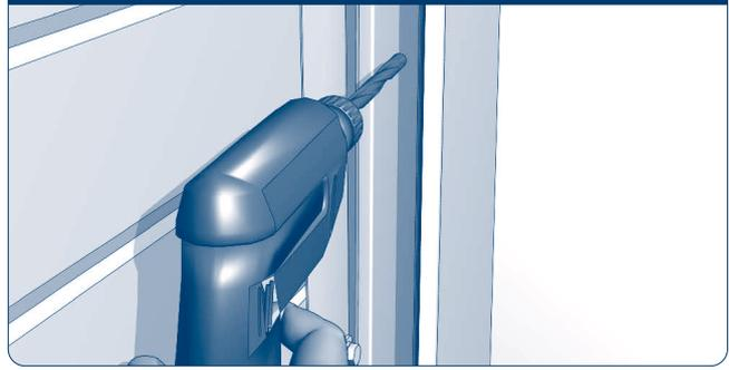
Откройте ворота и просверлите отверстие  $\varnothing 15$  мм в угловой стойке для вхождения ригеля замка.
